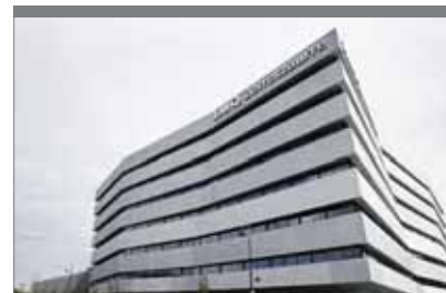
Nuevo Hospital IMQ Zorrotzaurre Bilbao: puertas de paso, puertas emplomadas, puertas resistentes al fuego, mamparas acristaladas, armarios, empanelados, cabinas sanitarias, mostradores.
