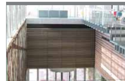
Rehabilitación Parador Nacional del Atlántico (Cádiz): puertas de paso, puertas isofónicas resistentes al fuego, armarios, empanelados, falsos techos, rodapié, cabinas sanitarias.
